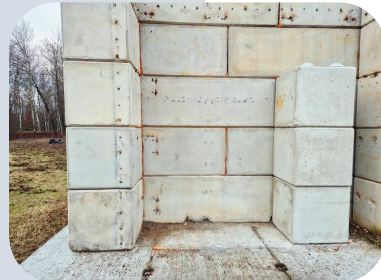
Ściana po wybuchu
