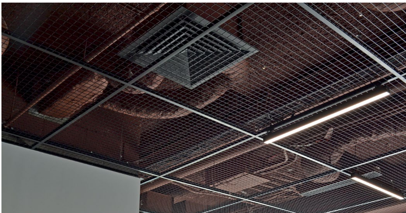
Fuzja Łódź MEDUSA GROUP WARSZAWA Sufit z siatki zgrzewanej na konstrukcji T24 w kolorze czarnym
